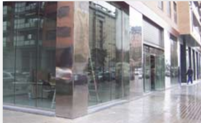
Exterior de la nueva sede.
