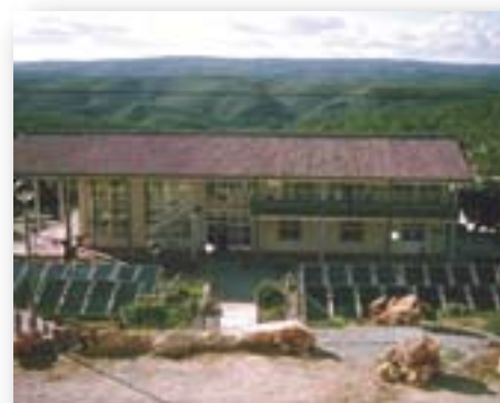
Infraestructuras de “El Teularet”.
