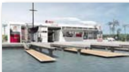
Lateral del edificio.
